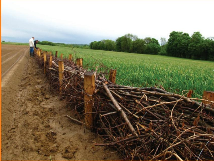
**fig. 4a** | Exemple d'aménagements mis en place à Schwindratzheim : un système de fascines mortes
