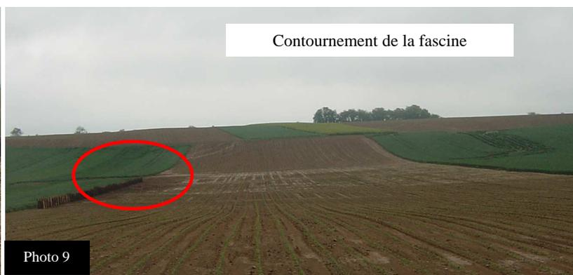
**Figure n°12** : photos des dysfonctionnements des mesures de lutte contre les coulées d'eaux boueuses à Ettendorf lors de l'événement du 11 mai 2009.
