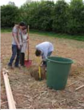
1° étape Implantation des cuves à ruissellement (Mai 2004)
