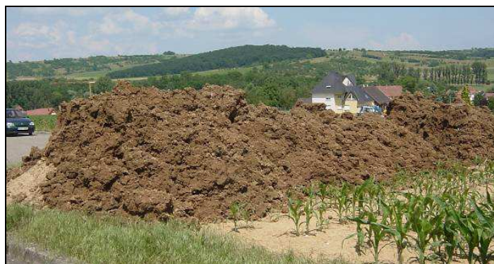
Figure 23 : Volume de terre extrait de la fascine n°1 à Alteckendorf, soit environ 50 m 3 en décompacté (CG67)
