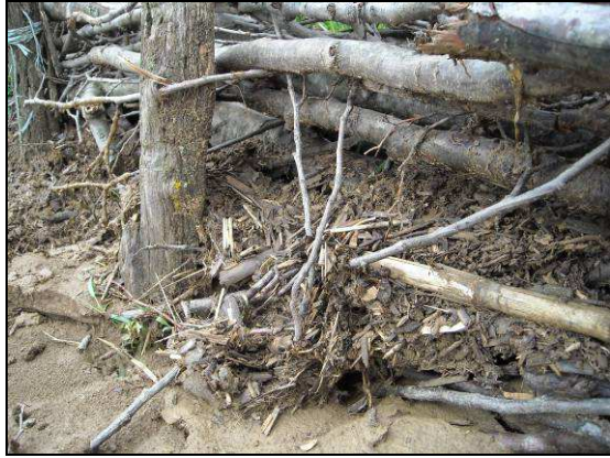
Figure 12 : Obstruction de la fascine par les fanes de maïs (CG67)
