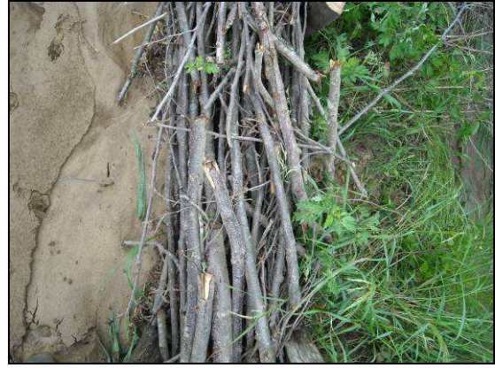
Figure 13 : Contraste entre l'amont de la fascine (côté chemin) et l'aval (côté fossé) (CG67)
